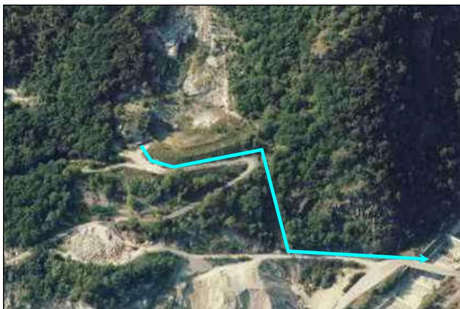
Scarico acque superficiali
