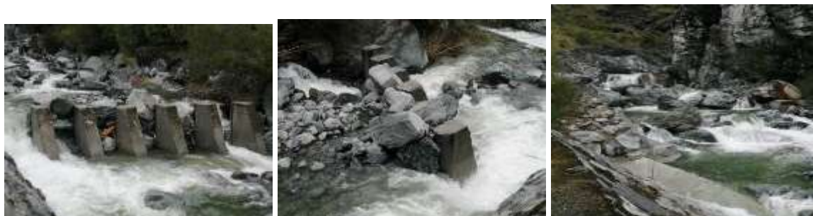
Alla foce del torrente poco a monte del ponte carraio in sinistra orografica, il muro di sponda ha ceduto formando un ampio antro. La fotografia sotto riportata descrive al meglio l'ampiezza del danno - Foto stazione forestale di Verres
