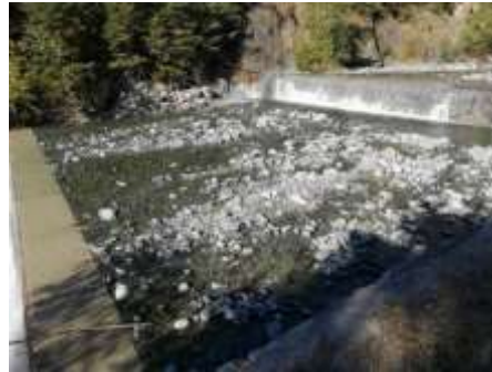
Vista vasche tra il secondo ponte su tre ed il ponte superiore – proseguendo in direzione monte, il materiale solido depositato aumenta di granulometria – Foto stazione forestale di Verres
