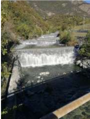
Vista vasche tra il secondo ponte su tre ed il ponte superiore – proseguendo in direzione monte, il materiale solido depositato aumenta di granulometria – Foto stazione forestale di Verres
