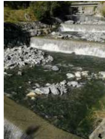
Vista vasche tra il secondo ponte su tre ed il ponte superiore – proseguendo in direzione monte, il materiale solido depositato aumenta di granulometria – Foto stazione forestale di Verres
