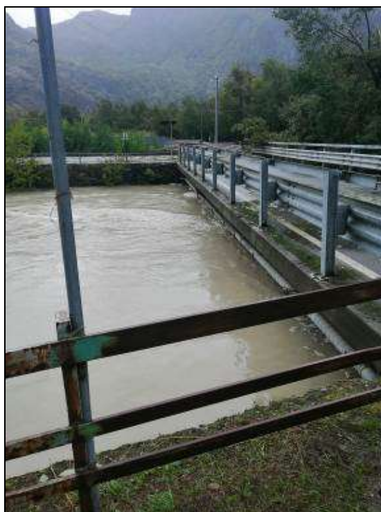
Ponte sul torrente Chalamy
