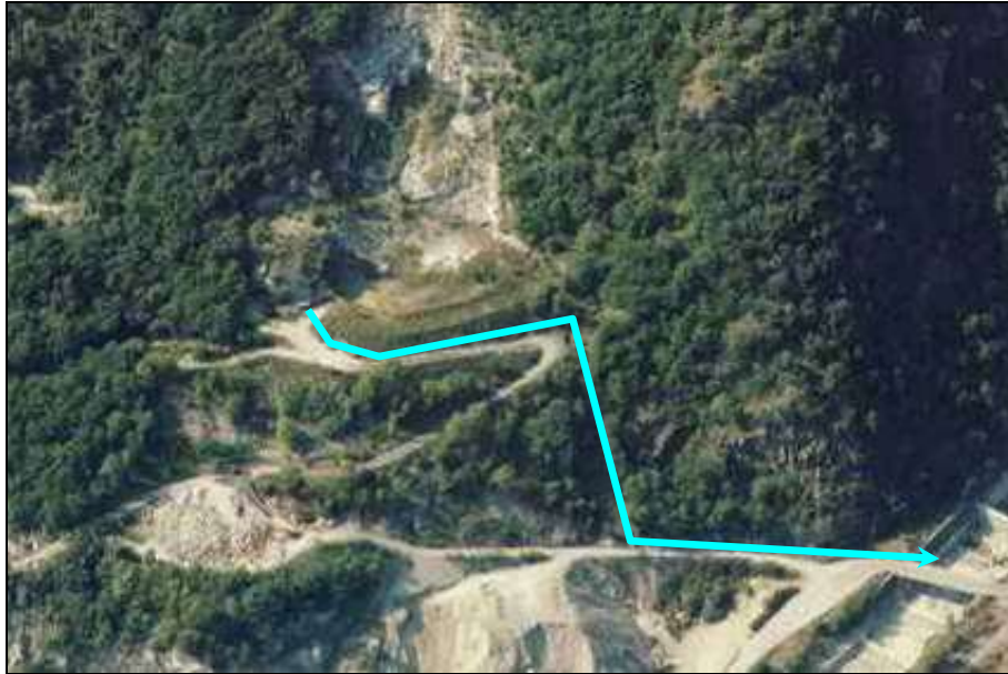
Scarico acque superficiali
