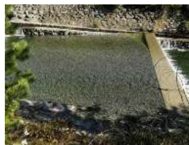
Vista delle due vasche colme di materiale subito a valle del secondo ponte su tre - Foto stazione forestale di Verres
